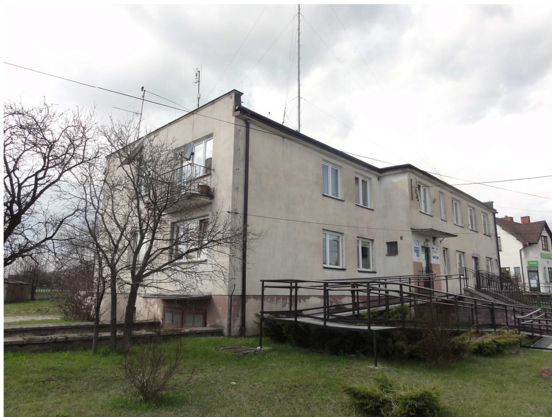
Zdjęcie nr 4 - Widok elewacji od strony południowo – wschodniej.
