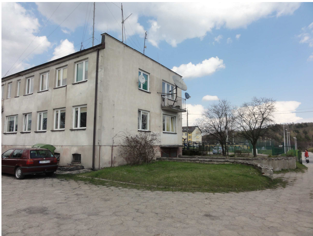
Zdjęcie nr 3 - Widok elewacji od strony południowo – zachodniej.
