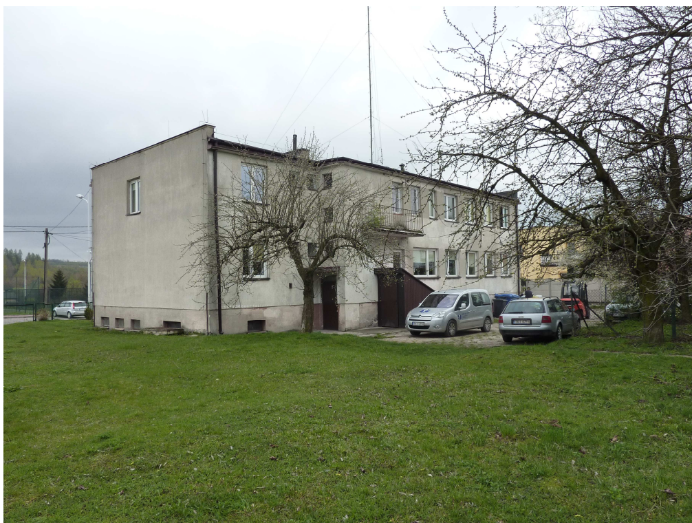
Zdjęcie nr 1 - Widok elewacji od strony północno – zachodniej.
