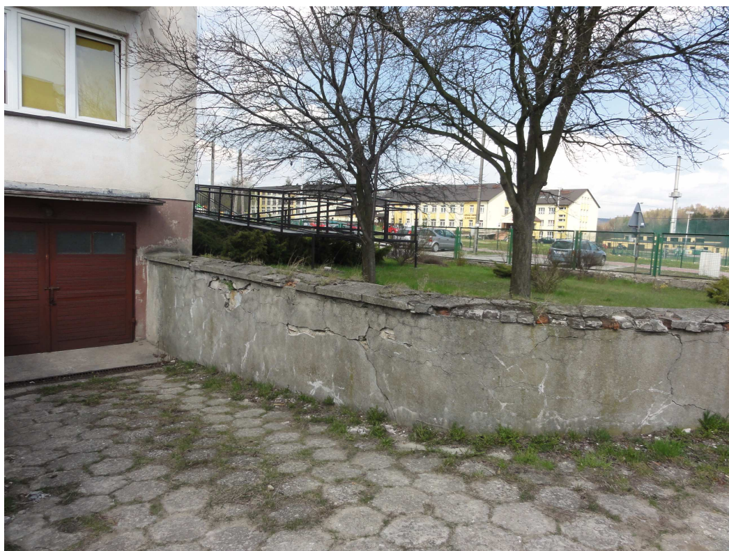
Zdjęcie nr 18 - Murki (ścianki oporowe) od strony południowej
