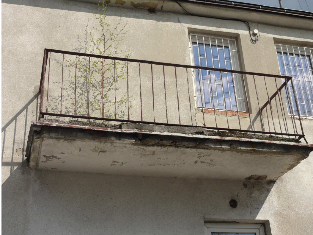
Zdjęcie nr 14 - Balkon od strony zachodniej
