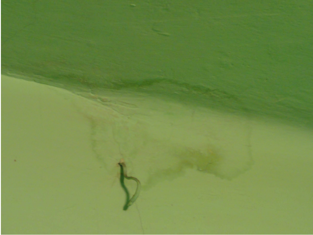
Zdjęcie nr 6 - Ściana wewnętrzne (klatka schodowa)
