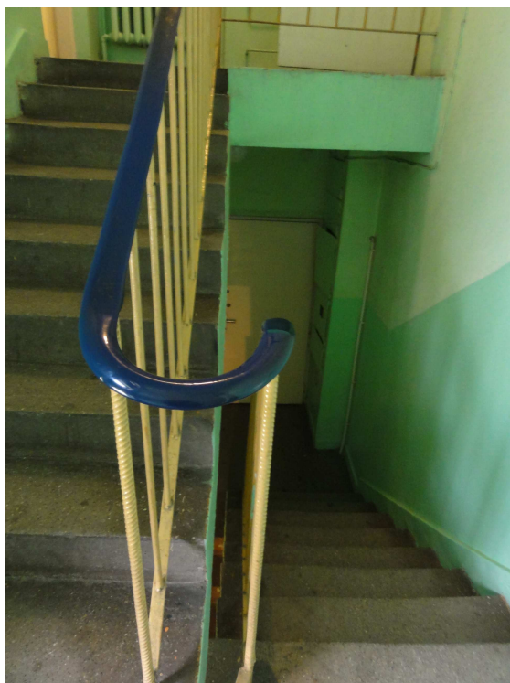
Zdjęcie nr 24 - Porecz przy schodach wewnętrznych.
