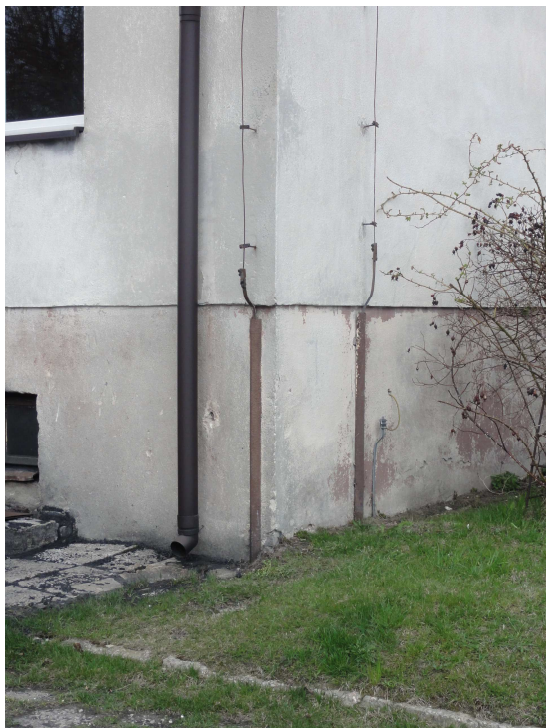
Zdjęcie nr 10 - Elewacja zach.-płd.
