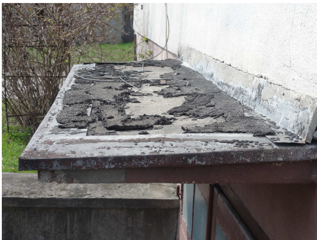
Zdjęcie nr 17 - Zadaszenie przy wjeździe do garażu
