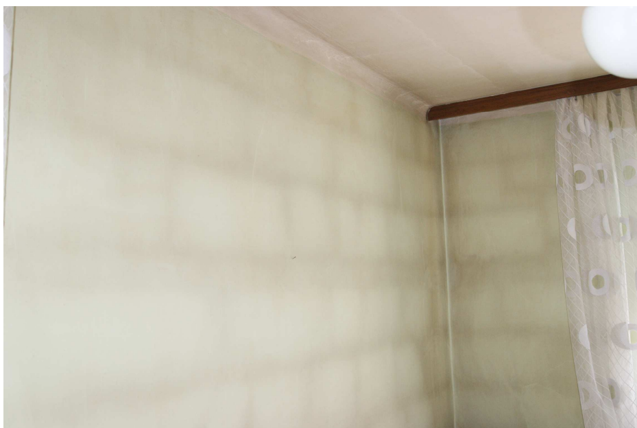
Zdjęcia nr 3,4,5 - Ściany zewnętrzne
