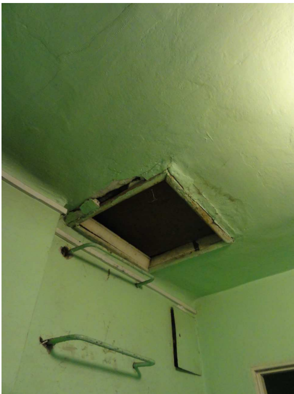
Zdjęcie nr 22,23 - Wylaz dachowy, szczeble włazowe
