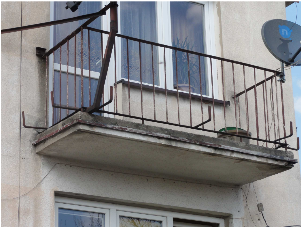
Zdjęcie nr 13 - Balkon od strony południowej
