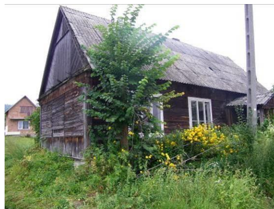
Fot. 8. Kakonin – budynek mieszkalny, przykład tradycyjnej architektury drewnianej
