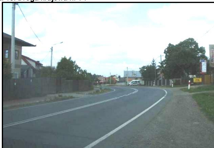
Fot. 15. Droga krajowa nr 74
